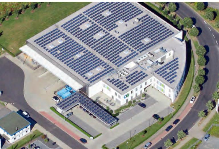
Die Photovoltaik-Anlage auf dem Dach produziert bis zu 240.000 kWh Strom jährlich. Der innovative Firmensitz entstand bereits 2013 im Plusenergie-Standard – wissenschaftlich begleitet von der Ostfalia Hochschule.
